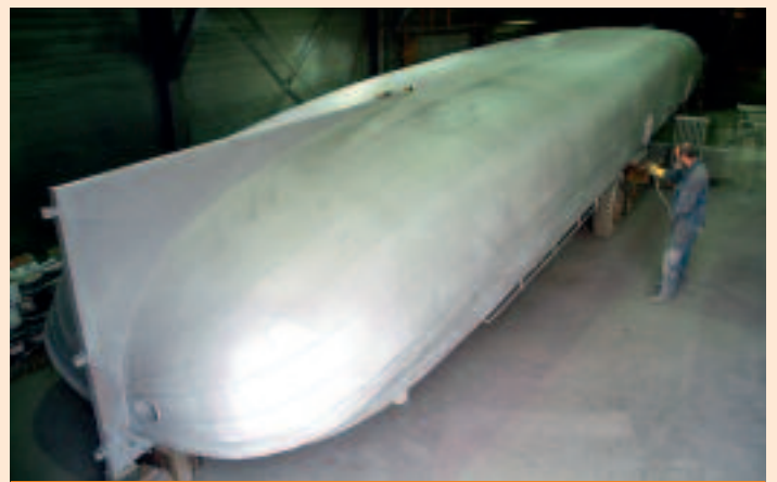
Na het stralen wordt het skûtsje gespoten
